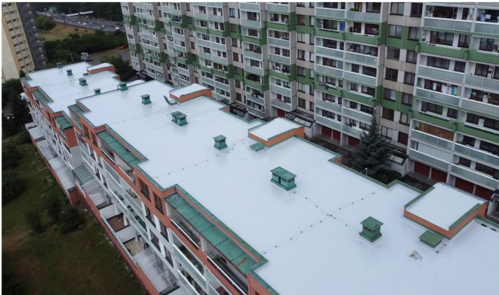
Střecha bytového domu, 1350 m 2 , 2023
