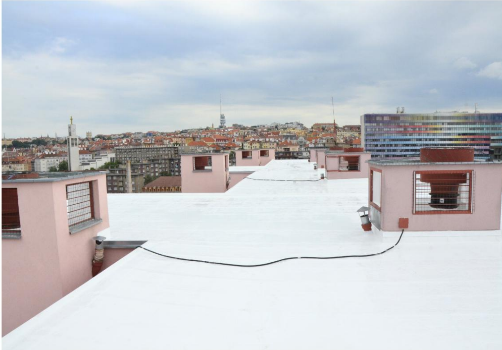
Střecha bytového domu, 1085 m 2 , 2022
